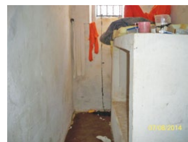
Interior de cela da galeria "casa velha"
