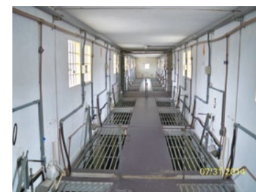
Galeria no presídio de Joinville com abertura superior das celas
