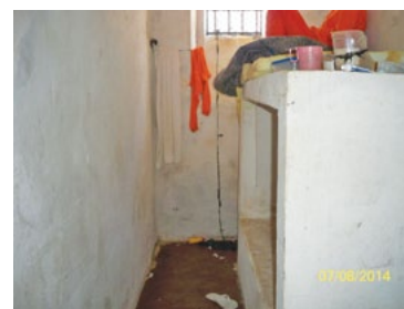
Interior de cela da galeria "casa velha"
