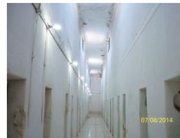
Galeria "casa velha"
