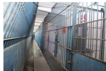
Galeria com abertura frontal das celas no complexo penitenciário estadual – São Pedro de Alcântara
