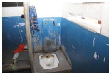
Cela com vaso sanitário quebrado
