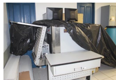
Equipamento de raio-x fora de operação por falta de manutenção e coberto devido às goteiras
